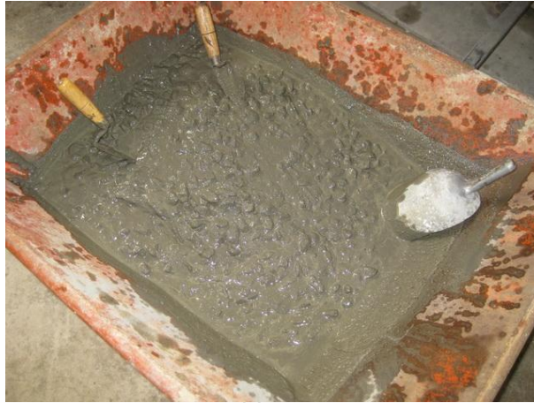
รูปที่ 3.4 การผสมคอนกรีตตามสัดส่วนผสม
