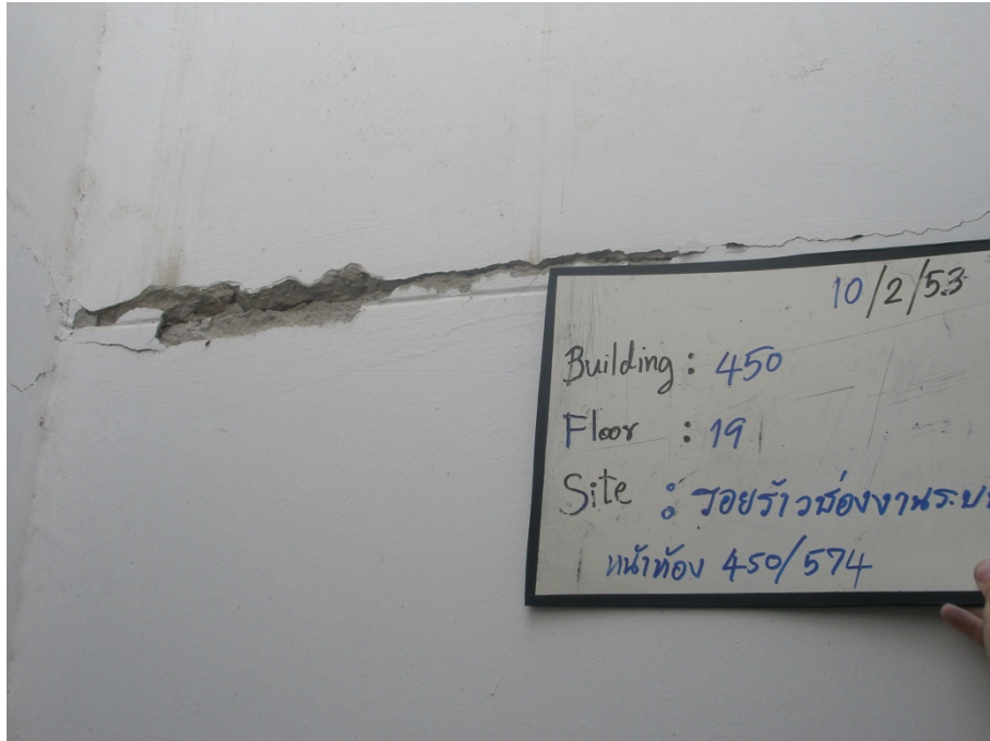
รูปที่ 4.60 ปัญหารอยร้าวช่องงานระบบหน้าห้อง 450/574 (อาคาร A ชั้น 19)
