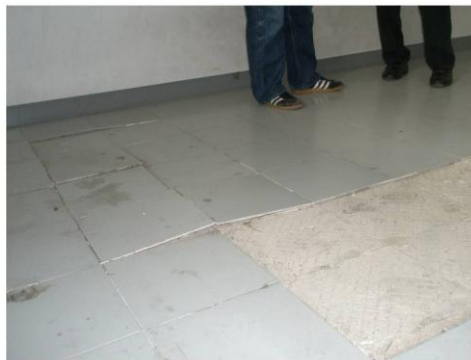
รูปที่ RNG 38/5 - 05 : ปัญหาการโก่งตัวและหลุดล่อนของกระเบื้อง (อาคาร 38 ห้อง 38/36)
