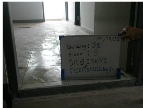
รูปที่ RNG 38/5 - 03 : ปัญหาการโค้งตัวของแนวกระเบื้อง (อาคาร 38 ห้อง 38/41)
