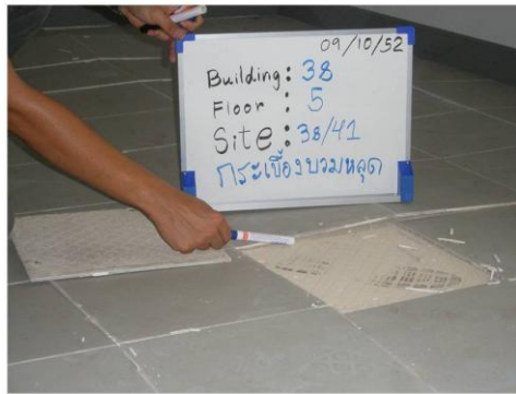
รูปที่ RNG 38/5 - 03a : ปัญหาการโก่งตัวและหลุดล่อนของกระเบื้อง (อาคาร 38 ห้อง 38/41)
