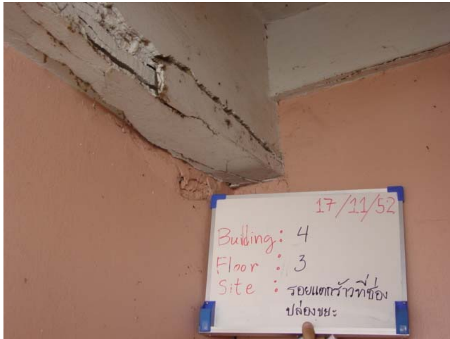
รูปที่ 4.28 ปัญหารอยแตกร้าวของคานที่ช่องปล่องขยะ (อาคาร 4)
