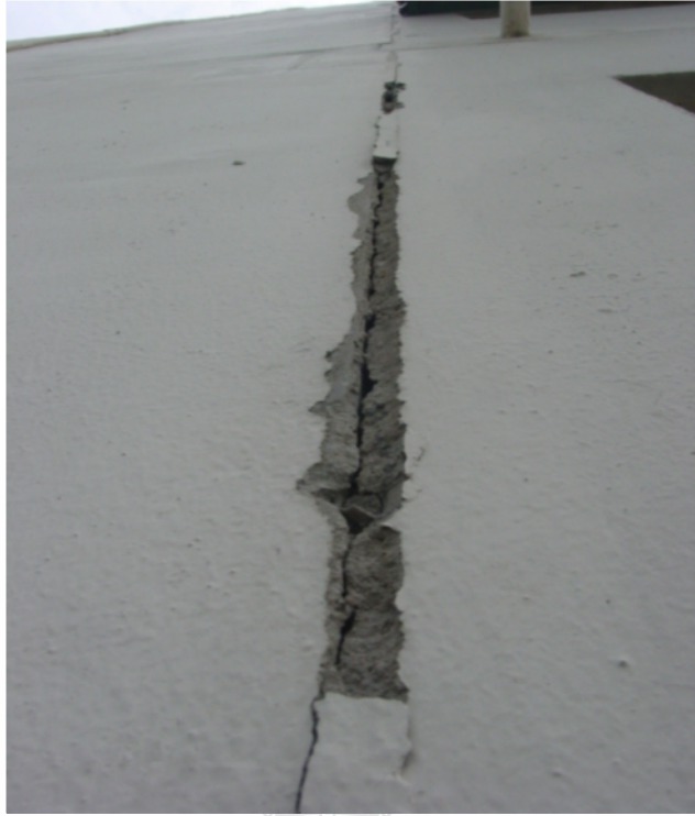
รูปที่ 4.10 ปัญหารอยต่อของผนังและเสา ด้านหน้าภายนอกอาคาร 17 มีการกะเทาะ
