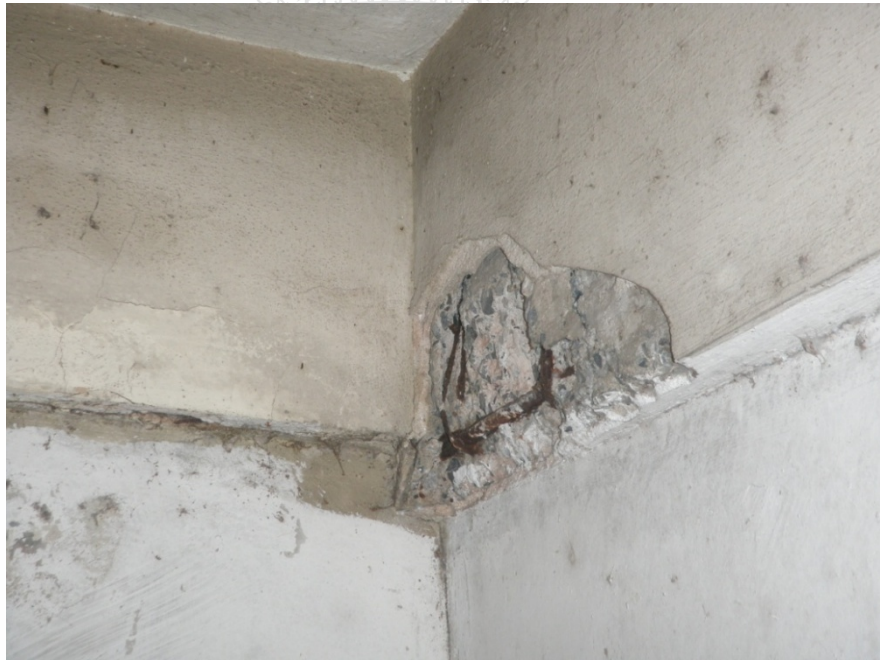
รูปที่ 4.48 ปัญหาคานกะเทาะเห็นเหล็กเสริมขึ้นสนิม (อาคาร 1 ชั้น 4 ปล่องขยะทิศตะวันตก)
