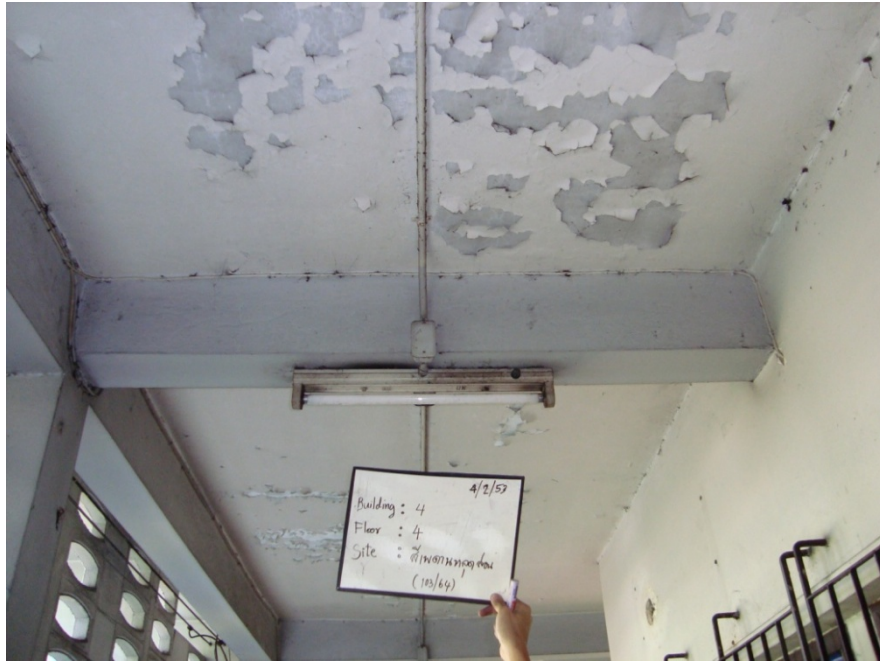
รูปที่ 4.43 ปัญหาสีปูนฉาบหลุดร่อน (อาคาร 4 หน้าห้อง 103/64)
