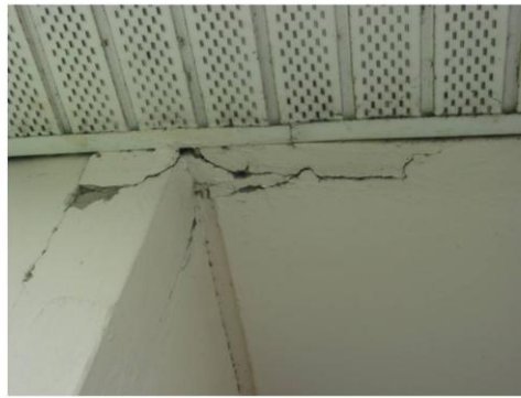
รูปที่ RNG 17/5 - 02 : ปัญหาช่วงรอยต่อบริเวณบนเพดานเกิดรอยร้าว (อาคาร 17)
