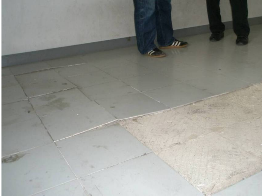
รูปที่ 4.3 ปัญหาการ โกงตัวและล่อนของแผ่นพื้นกระเบื้อง (อาคาร 38 ห้อง 38/36)
