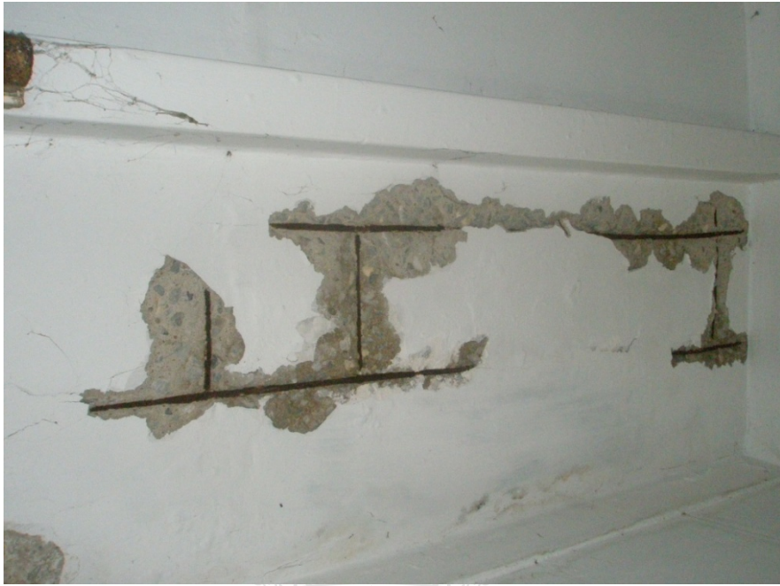
รูปที่ 4.57 ปัญหาท้องพื้นชั้น 3 เกิดการกะเทาะเห็นเหล็กเสริมเกิดสนิม
