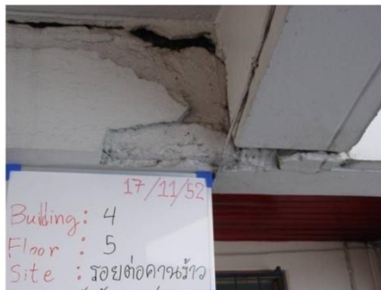
รูปที่ NRN 4/5-02 : ปัญหาการแตกร้าวและการหลุดล่อนของชั้นปูนฉาบ บริเวณส่วนต่อคาน (อาคาร 4 หน้าห้อง 51/148)
