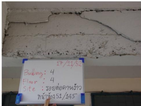
รูปที่ NRN 4/4-01 : ปัญหาการแตกร้าวและการหลุดล่อนของชั้นปูนฉาบ บริเวณส่วนต่อคาน (อาคาร 4 หน้าห้อง 51/145)
