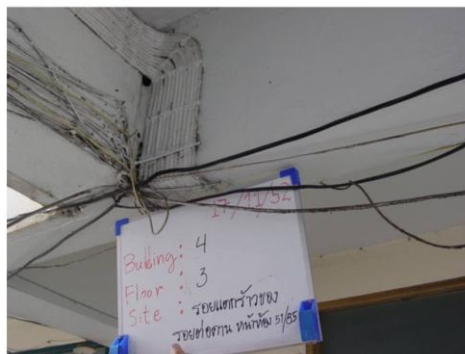
รูปที่ NRN 4/3-01 : ปัญหาการแตกฝ้าและการหลุดล่อนของชั้นปูนฉาบ บริเวณส่วนต่อคาน (อาคาร 4 หน้าห้อง 51/85)
