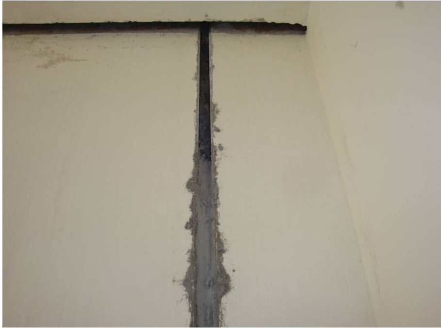
รูปที่ 4.24 ปัญหาช่องว่างที่เกิดจากการอุด joint ด้วยโฟม (อาคาร 20 ห้อง 76/13)
