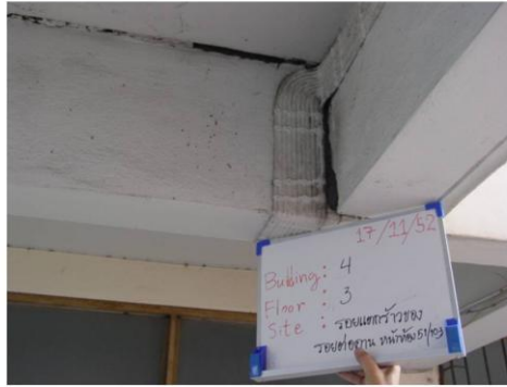
รูปที่ NRN 4/3-02 : ปัญหาการแตกร้าวและการหลุดล่อนของชั้นปูนฉาบบริเวณส่วนต่อคาน (อาคาร 4 หน้าห้อง 51/103)
