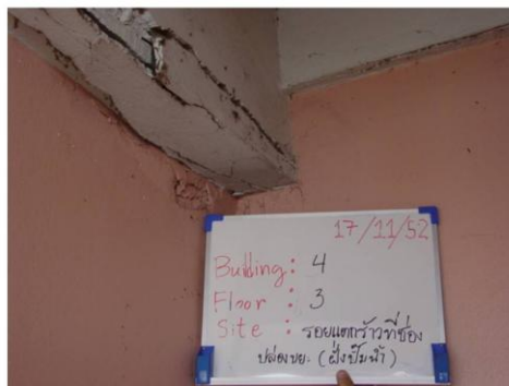
รูปที่ NRN 4/3-04 : ปัญหาการแตกร้าวและการหลุดล่อนของชั้นปูนฉาบช่องปล่องขยะ (อาคาร 4 ชั้น 3)
