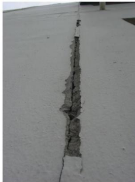
รูปที่ RNG 17/1 - 01 : ปัญหารอยต่อของผนังและเสา ด้านหน้าภายนอก อาคาร 17 มีการกะเทาะ
