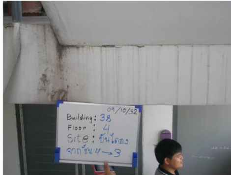
รูปที่ RNG 38/4 - 01 : ปัญหาการรื้อซึมรอยต่อบริเวณชายพนักบันไดชั้น 4ลง ชั้น 3 (อาคาร 38)
