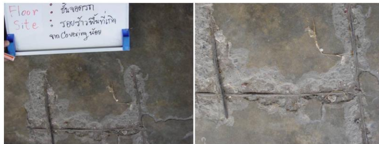
รูปที่ NRN 2/1-01 : ปัญหาพื้นเกิดรอยร้าว (อาคาร 2)
