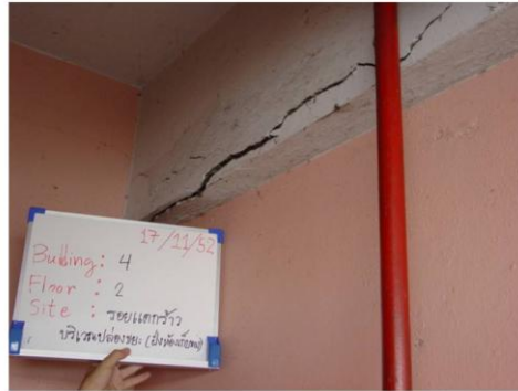
รูปที่ NRN 4/2-01 : ปัญหารอยแตกฝ้าของคานที่ช่องปล่องขยะ (อาคาร 4)
