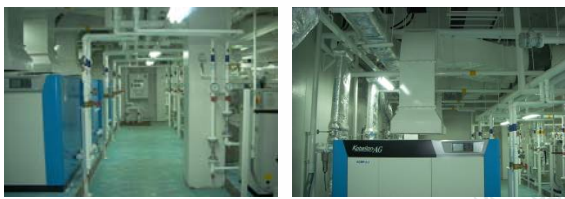
รูปที่ 1. ระบบอากาศอัดที่ติดตั้งการระบายความร้อนทิ้ง
