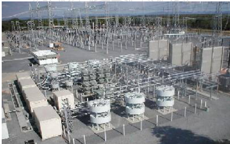
รูปที่ 2.14 ลักษณะการติดตั้งของ SVC [19]
