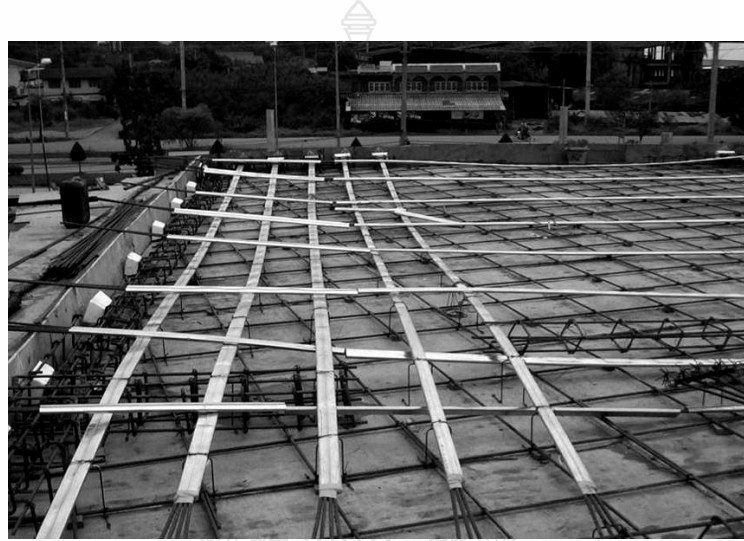
รูปที่ 2.2 ขั้นตอนการก่อสร้างพื้นคอนกรีตอัดแรง
