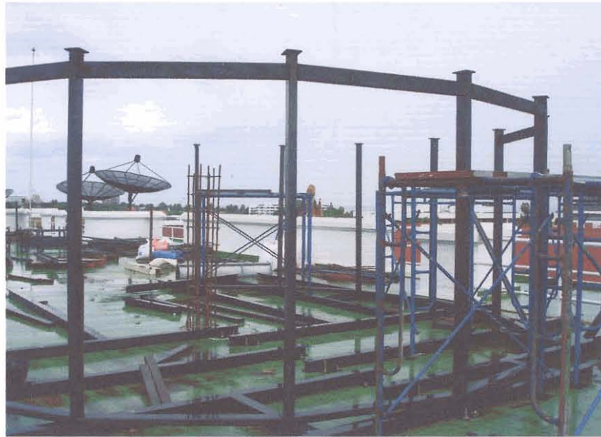
ภาพที่ 3.27 ติดตั้งเสาของ โดมยี่ดัดกับเหล็กรูปพรรณ
