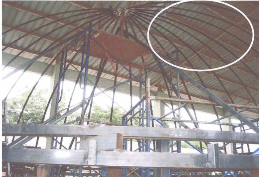
ภาพที่ 3.15 ประกอบตัวโครงรูปโค้งกับตัวยึดยอดและกับฐานตัววาง
