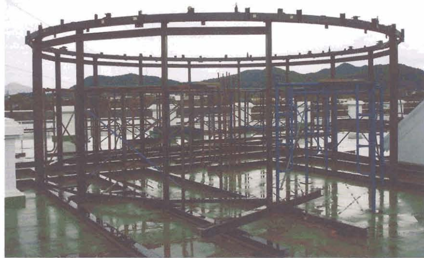
ภาพที่ 3.29 ติดตั้งเสา
