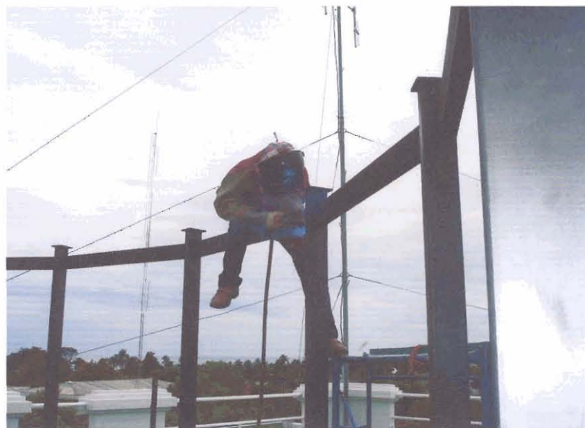
ภาพที่ 3.28 เชื่อมเสาเพื่อเป็นฐานของการขึ้น โครงตัวโดม
