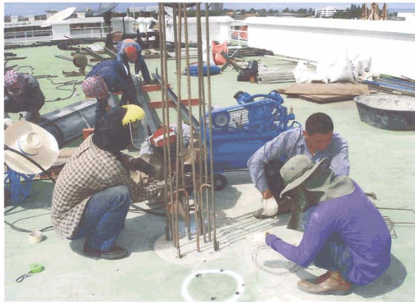
ภาพที่ 3.25 เตรียมโครงสำหรับทเสาปูนเพื่อเป็นฐานสำหรับวางตัวกล้องดูดาว
