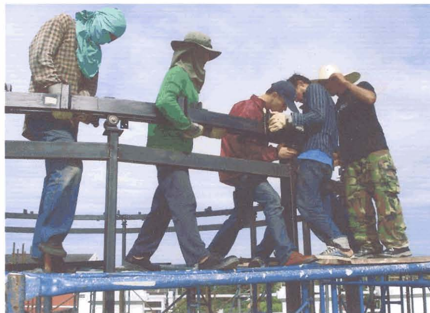
ภาพที่ 3.30 ติดตั้งชุดขับเคลื่อนของมอเตอร์เพื่อประกอบตัวราง
