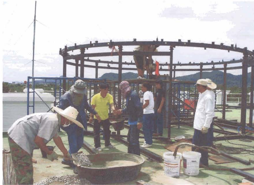
ภาพที่ 3.31 เทเสาสำหรับวางฐานกลี้งดูดาว
