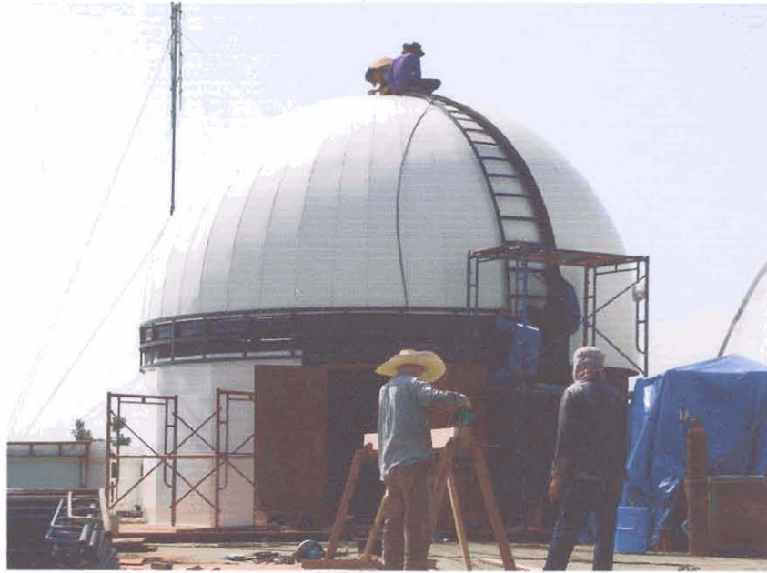
ภาพที่ 3.37 หุ้มโครงตัวโดมด้วยแผ่นอลูมิเนียมและเก็บรายละเอียดของสี
