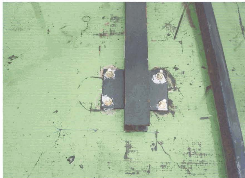
ภาพที่ 3.26 ติดตั้งเหล็กรูปพรรณเพื่อถ่ายน้ำหนักลงตัวคานของตัวอาคาร
