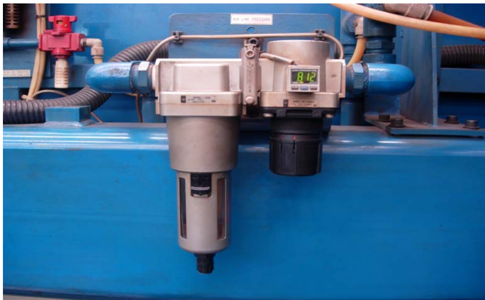
รูปที่ 3.18 ตรวจสอบแรงดันลม
