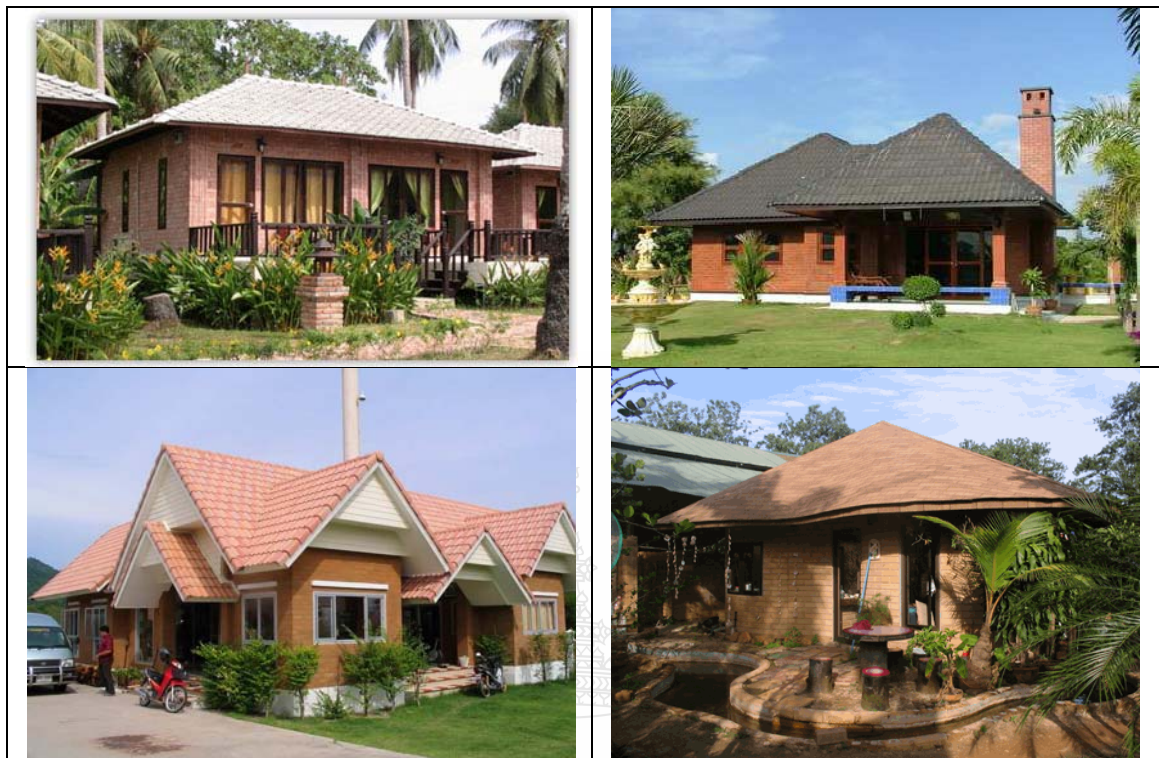
ภาพที่ 3.12 แสดงการนำบล็อกประสานก่อสร้างเป็นบ้านพักอาศัย
