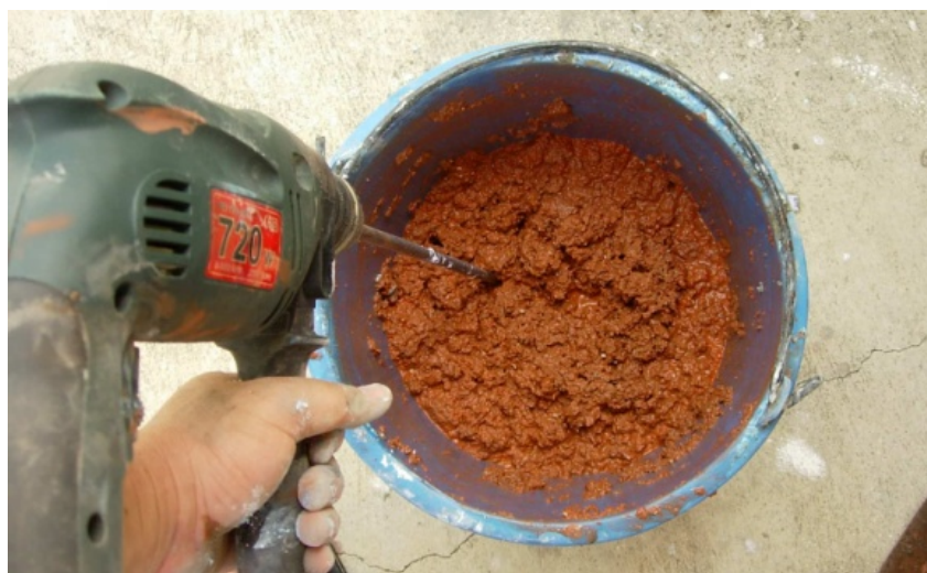
ภาพที่ 4.10 แสดงเครื่องมือผสม (ใบมีดและสว่านไฟฟ้า)
