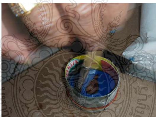
ภาพที่ 21 การทาน้ำมันให้ทั่วภายในส่วนที่จะเทปูนพลาสติก
