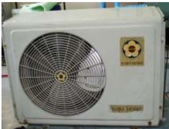
ภาพที่ 3.7 ชุดแอร์ระบายความร้อนด้วยอากาศ
