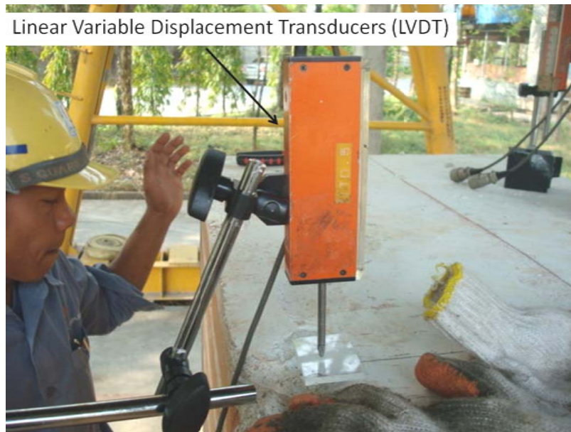
รูปผนวกที่ ข15 การติดตั้ง LVDT
