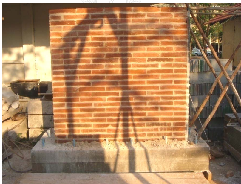
รูปผนวกที่ ข12 ผนังอิฐที่ก่อเสร็จเรียบร้อยแล้ว
