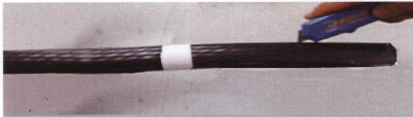
รูปที่ 3.44 การกรีดที่ผิวของ Semi-Conducting Tape
