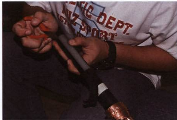
รูปที่ 3.46 การลอก Semi-Conducting Tape ออก
