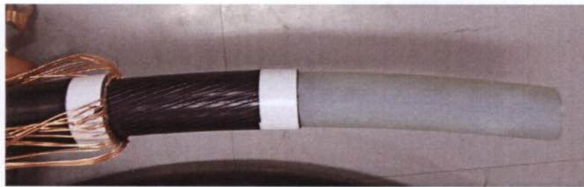
รูปที่ 3.47 ตัด Semi-Conducting Tape ที่ลอกออก
