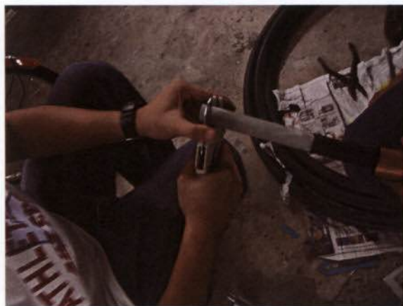
รูปที่ 3.48 คั้วน Insulation Shield
