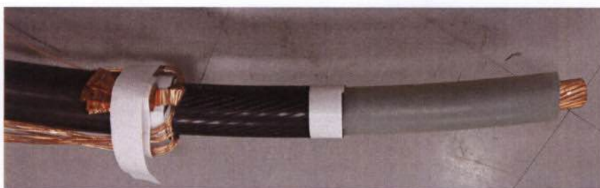
รูปที่ 3.49 งัด Insulation Shield ออก
