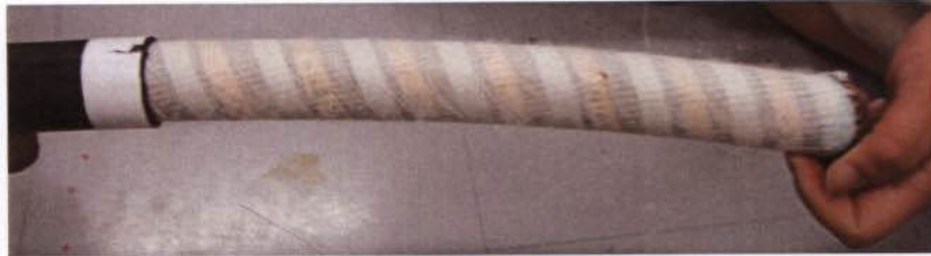
รูปที่ 3.40 ทำการลอกผิวเปลือกนอก(Sheath) ออก
