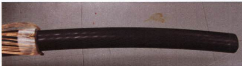
รูปที่ 3.42 ลักษณะการเก็บ Copper Shield Tape
