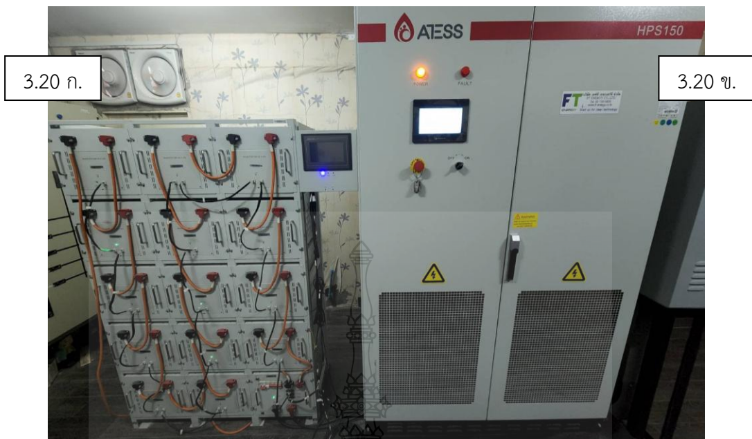
รูปที่ 3.20 ก. แบตเตอรี่ลิเธียม 100 กิโลวัตต์-ชั่วโมง และ ข. อินเวอร์เตอร์ไฮบริด 150 กิโลวัตต์
