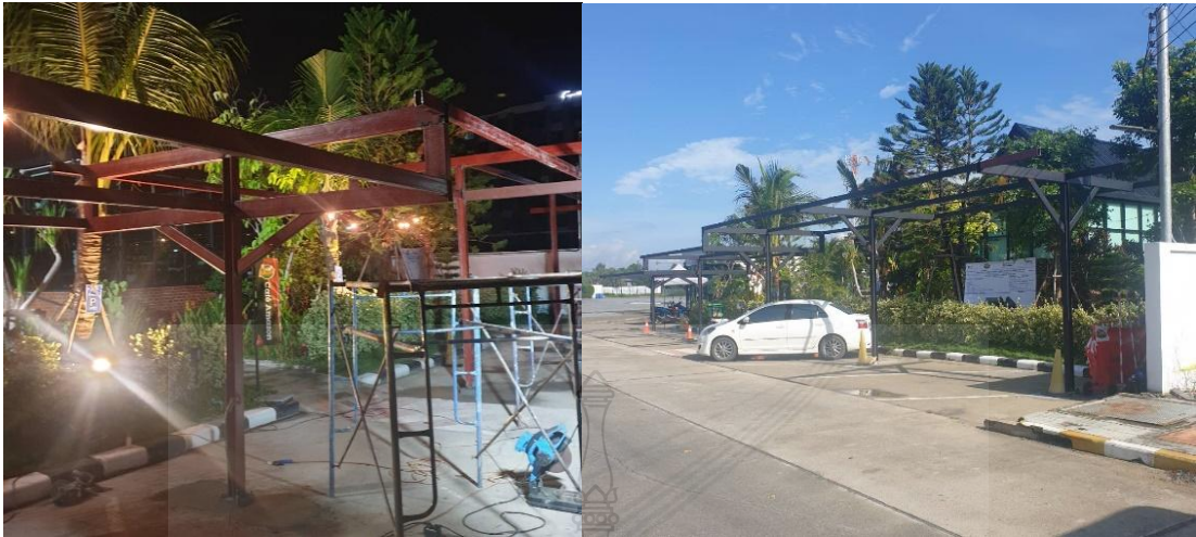
รูปที่ 3.11 การก่อสร้างโครงอาคารจอดรถ
