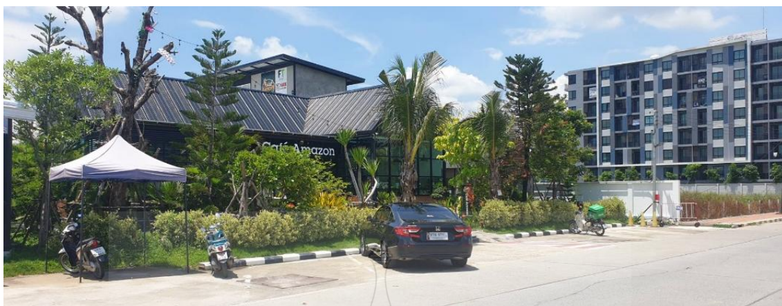
รูปที่ 3.9 พื้นที่หน้างานจริงก่อนทำการก่อสร้าง
