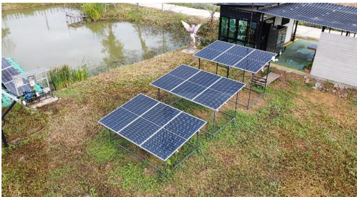
รูปที่ 3.1 การติดตั้งเซลล์แสงอาทิตย์ที่ระดับความสูง 1 เมตร, 1.5 เมตร และ 2 เมตร
