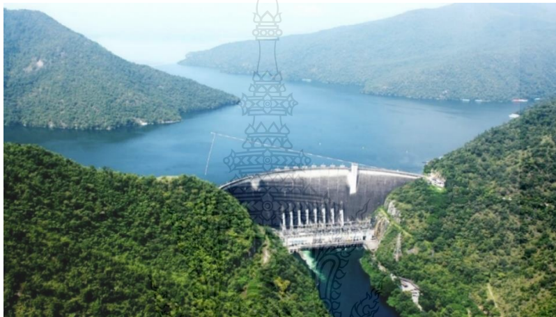
รูปที่ 2.4 ลักษณะเชื้อนโค้ง (Arch Dam)
