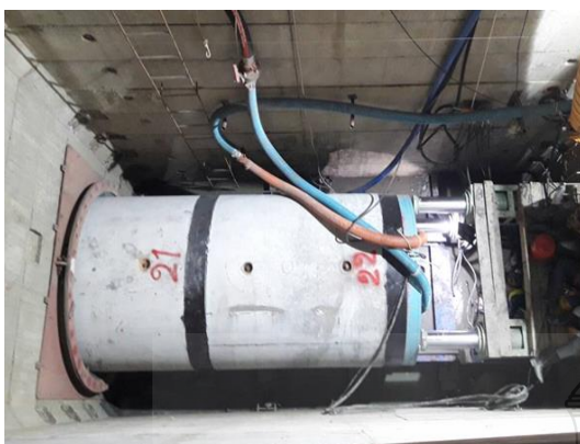
รูปที่ 2.7 การก่อสร้างด้วยวิธีดันท่อลอด (Pipe Jacking) [ฤทธิชัย]
