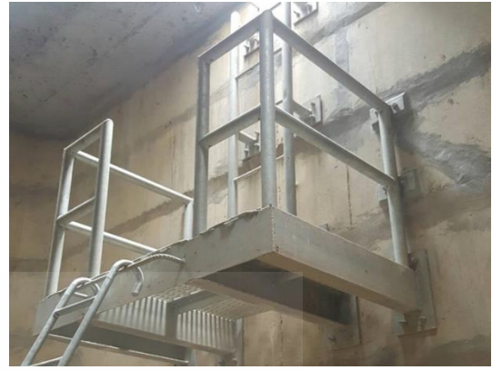
รูปที่ 2.9 อุปกรณ์ภายในบ่อพักสำหรับอำนวยความสะดวกในการเข้าปฏิบัติงาน [ฤทธิ์ชัย]
