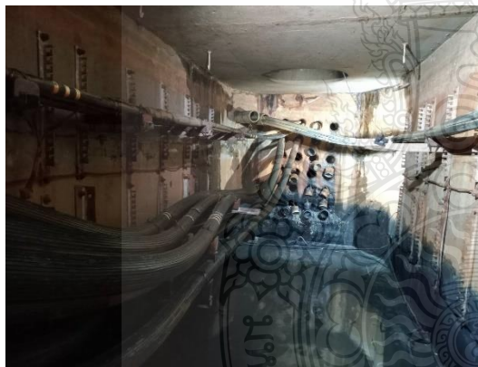
รูปที่ 2.10 อุปกรณ์ภายในบ่อพักสำหรับรองรับการติดตั้งสายไฟฟ้าใต้ดิน [ฤทธิ์ชัย]
