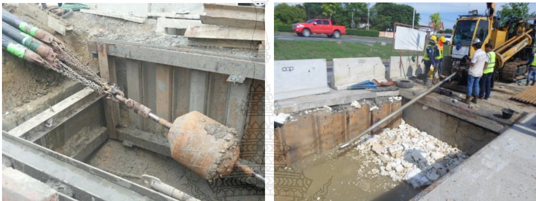
รูปที่ 2.2 การก่อสร้างท่อร้อยสายไฟฟ้าใต้ดิน ด้วยวิธีดิ่งท่อลอด (HDD) [ฤทธิ์ชัย]
