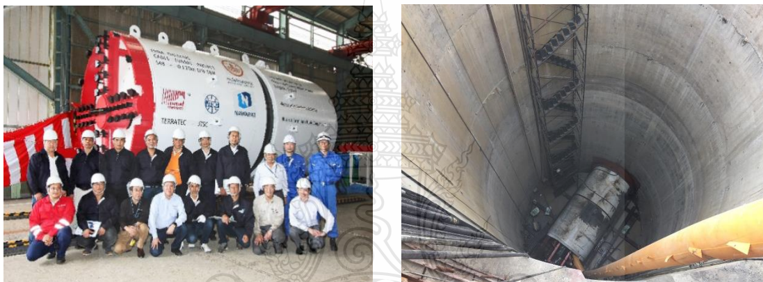
รูปที่ 2.4 การก่อสร้างอุโมงค์สายไฟฟ้าใต้ดิน ด้วยวิธีการก่อสร้างอุโมงค์ (Tunneling) [ฤทธิ์ชัย]
