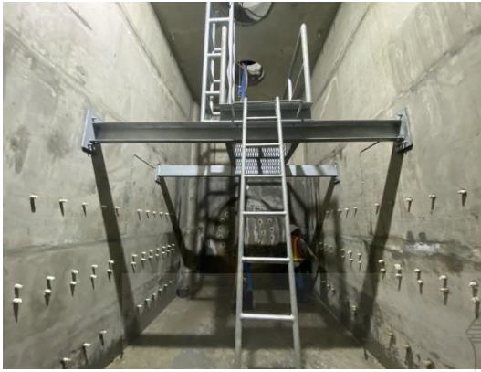
รูปที่ 2.9 อุปกรณ์ภายในบ่อพักสำหรับอำนวยความสะดวกในการเข้าปฏิบัติงาน [ฤทธิ์ชัย]
