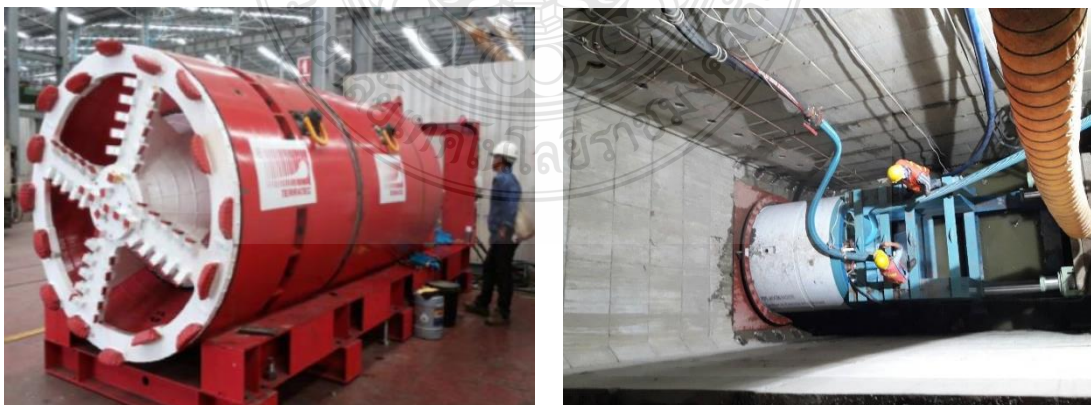
รูปที่ 2.3 การก่อสร้างท่อร้อยสายไฟฟ้าใต้ดิน ด้วยวิธีดันท่อลอด (Pipe Jacking) [ฤทธิ์ชัย]
