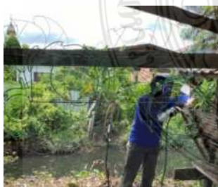
ภาพที่ 4.46 การเชื่อม และวางตำแหน่งเพื่อทำการเชื่อม
