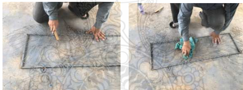
ภาพที่ 4.48 การทำความสะอาดด้วยแปรงลวดและการทำความสะอาดด้วยผ้าชุบน้ำ
