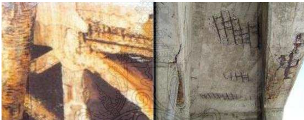
รูปที่ 2.12 ลักษณะการทำลายของสารประกอบซัลเฟตต่อคอนกรีต [1]
