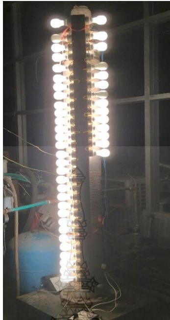
รูปที่ 3.13 ทดสอบเปิดหลอดไฟที่ติดตั้งเสร็จแล้ว
