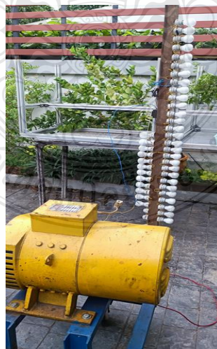
รูปที่ 3.12 การติดตั้งโหลดหลอดไฟขนาดทั้งหมด 4.5 kW
