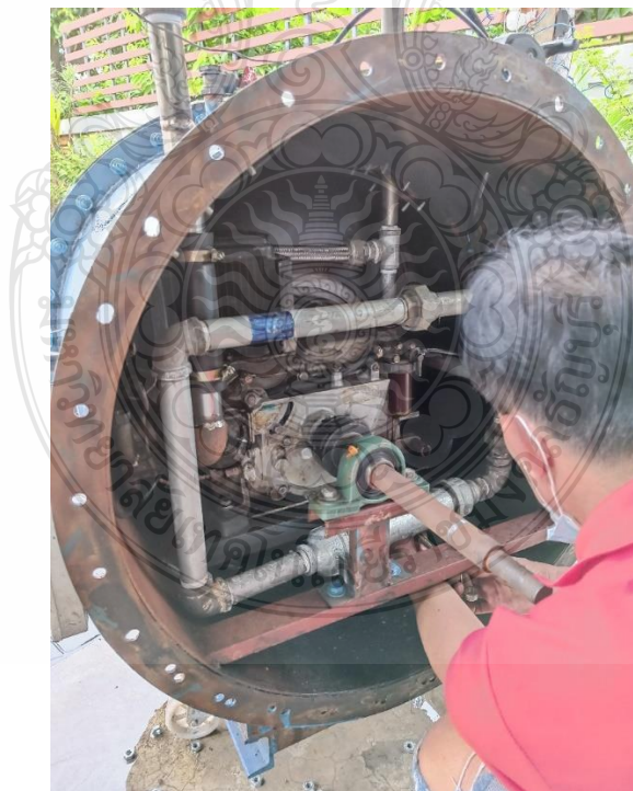
รูปที่ 3.10 ติดตั้งระบบท่อไอเสียแบบวนกลับได้
