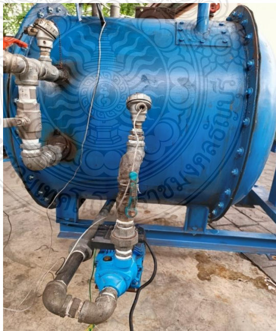
รูปที่ 3.14 ติดตั้งเทอร์โมคัปเปิ้ลไว้ที่ท่อน้ำวน
