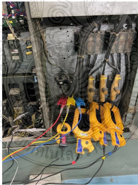
รูปที่ 3.11 การติดตั้งชุดวัดแรงดันไฟฟ้าและกระแสไฟฟ้าของลิฟต์ในตู้ควบคุม
