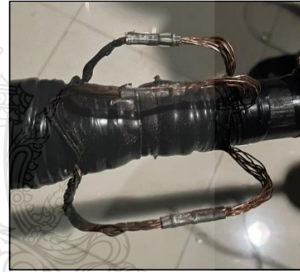
รูปที่ 3.9 แบบจำลองภาพตัดจุดต่อสายเคเบิลใต้ดิน XLPE 12/20 24(kV) ขนาด 400 mm 2 แบบต่อกราวนด์ 3 จุด ขั้วต่อกราวนด์แบบกลม
