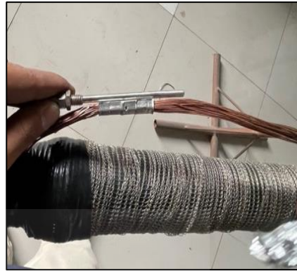
รูปที่ 3.5 แบบจำลองภาพตัดจุดต่อสายเคเบิลใต้ดิน XLPE 12/20 24(kV) ขนาด 400 mm 2 แบบต่อกราวนด์ 1 จุด ขั้วต่อกราวนด์แบบกลม
