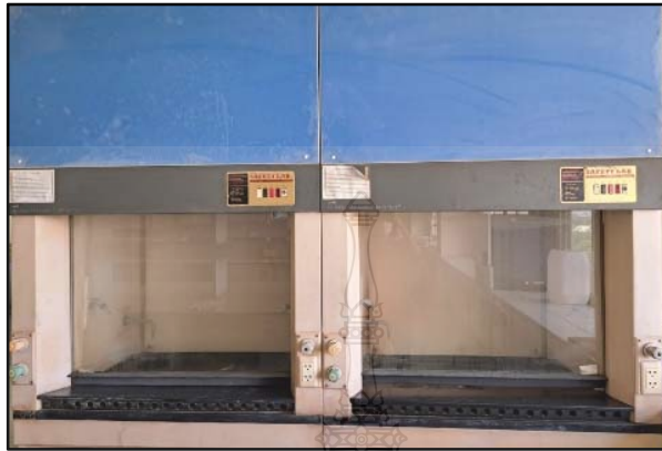
ภาพที่ 3.32 ตู้ดูดควัน (Hood)
