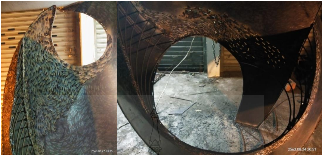
ภาพที่ 3.161 แสดงเหล็กโครงสร้าง และเหล็กเส้นที่เป็นส่วนประกอบของรูปทรงผลงานชิ้นที่ 4
