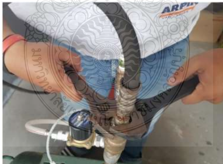
รูปที่ 3.19 ติดตั้งสายส่งน้ำกับข้อต่อที่ถังเก็บอากาศ
