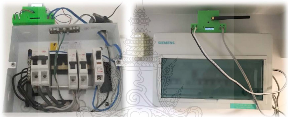
รูปที่ 3.51 จุดติดตั้งอุปกรณ์ NILM ของบ้านตัวอย่าง
