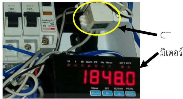
รูปที่ 2.25 ตัวอย่างการติดตั้งอุปกรณ์ส่วนตรวจวัด
