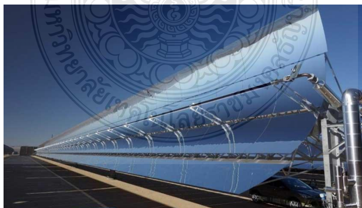
รูปที่ 2.19 การผลิตไฟฟ้าจากความร้อนแสงอาทิตย์แบบระบบรางพาราโบลิก[37]
