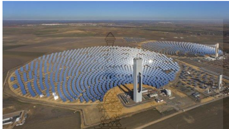
รูปที่ 2.20 การผลิตไฟฟ้าจากความร้อนแสงอาทิตย์ระบบหอคอย[37]
