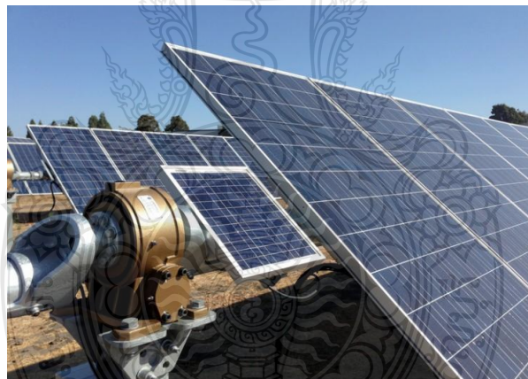
รูปที่ 2.18 เซลล์แสงอาทิตย์แบบหมุนตามดวงอาทิตย์ (Tracking System)[36]
