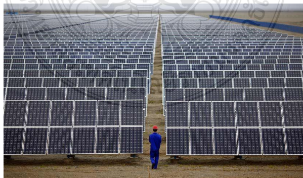
รูปที่ 2.16 เซลล์แสงอาทิตย์แบบยึดติดอยู่กับที่ (Fixed System)[36]
