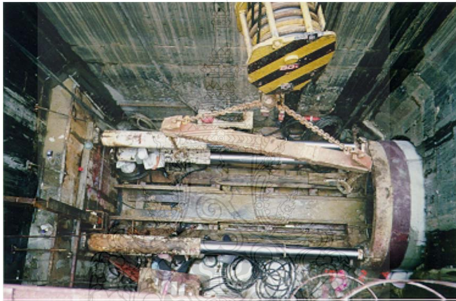
รูปที่ 2.8 แม่แรงไฮดรอลิก (Hydraulic Jacks) [7]
