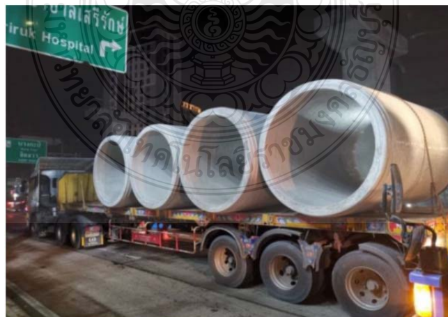
รูปที่ 2.7 ท่อดัน (Jacking Pipes)
