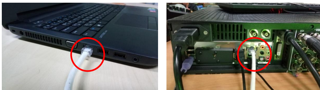
ภาพที่ 4-47 การต่อสายสัญญาณต่ออินเทอร์เน็ตที่เครื่องคอมพิวเตอร์และเครื่อง Switcher
