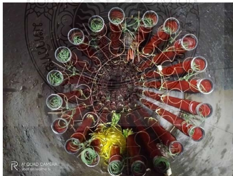
รูปที่ 3.4 การติดตั้งหีเหล็กภายในท่อPipe Jacking
