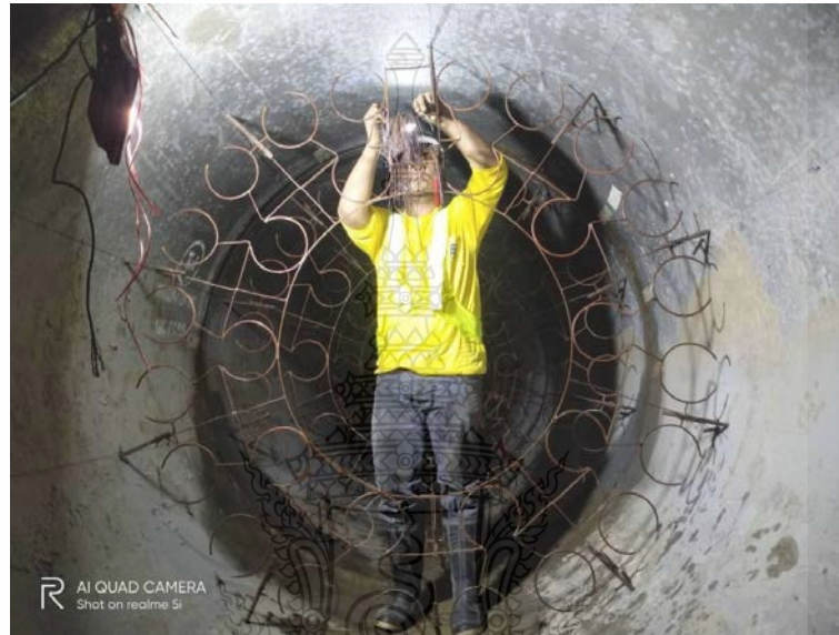
รูปที่ 3.4 การติดตั้งหีเหล็กภายในท่อPipe Jacking
