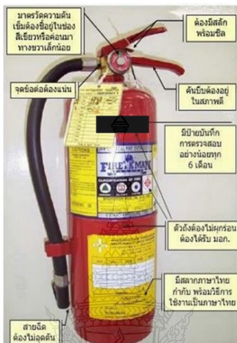
ภาพที่ 3.7 แสดงลักษณะการตรวจสอบสภาพถังดับเพลิงแบบมือถือ
