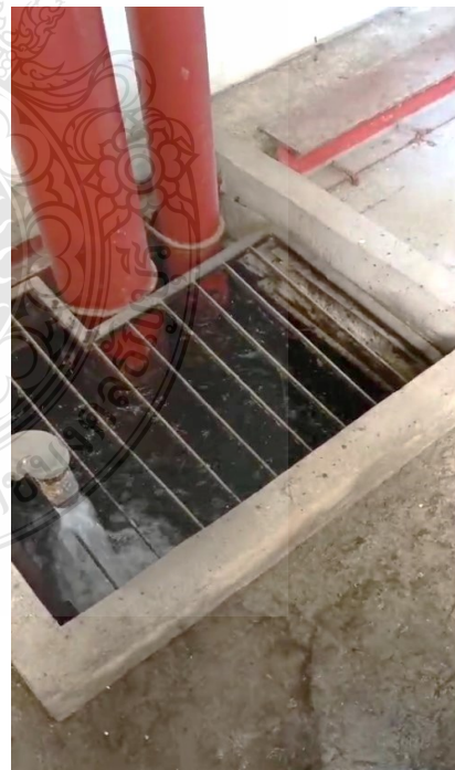
ภาพที่ 4.39 แสดงจุดที่ต้องตรวจสอบขณะเครื่องสูบน้ำดับเพลิงทำงาน
