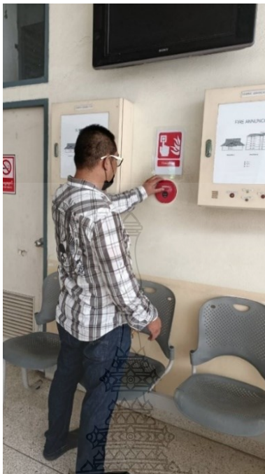
ภาพที่ 4.35 แสดงสาธิตการตรวจสอบสภาพกระดิ่งสัญญาณแจ้งเหตุเพลิงไหม้
