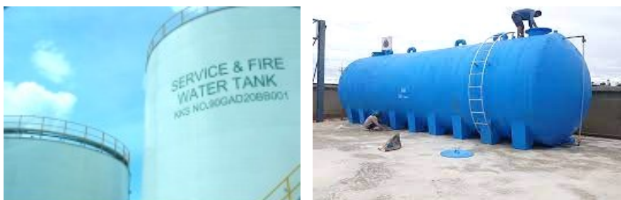
ภาพที่ 3.3 แสดงแท็งก์น้ำสำรองสำหรับดับเพลิง ที่มา : สมาคมส่งเสริมความปลอดภัยและอนามัยในการทำงาน (2564, หน้า 3)
