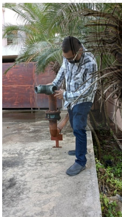
ภาพที่ 4.41 แสดงสาธิตการตรวจสอบหัวจ่ายน้ำดับเพลิง
