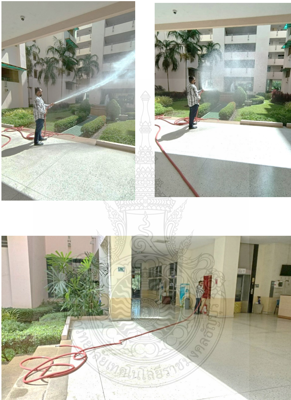
ภาพที่ 4.31 แสดงสาธิตการตรวจสอบสายฉีดน้ำดับเพลิงภายในตู้ดับเพลิง (ต่อ)
