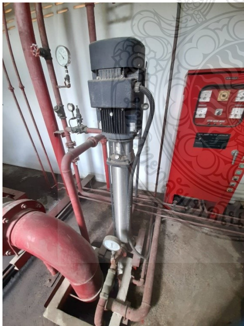
ภาพที่ 4.39 แสดงจุดที่ต้องตรวจสอบขณะเครื่องสูบน้ำดับเพลิงทำงาน
