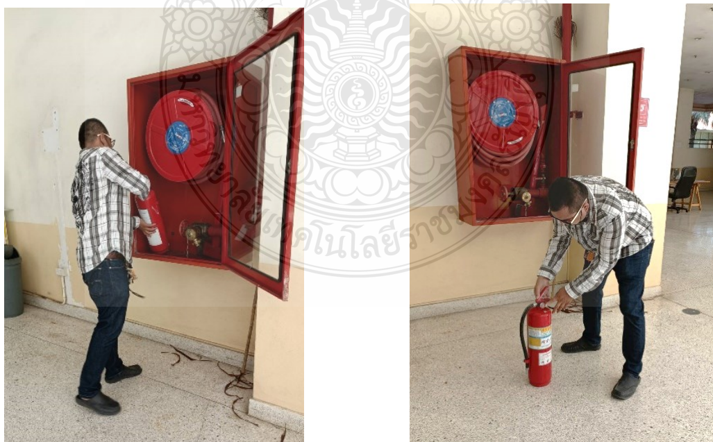
ภาพที่ 4.28 แสดงการตรวจสอบภายนอกถังดับเพลิงแบบมือถือ
