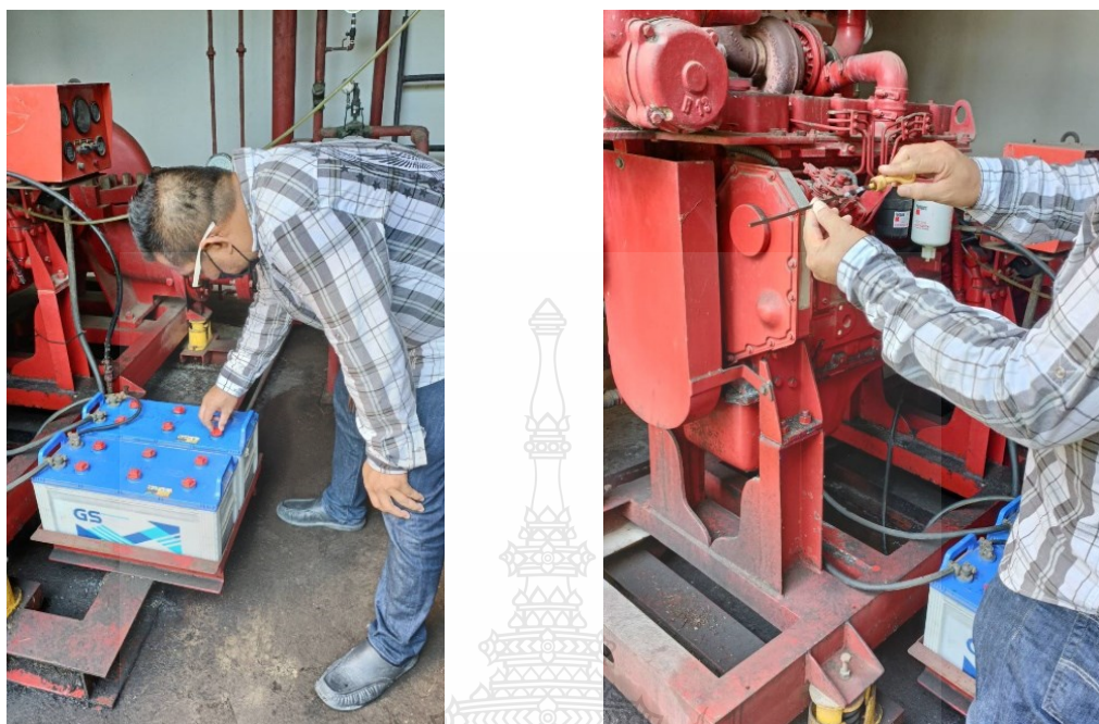
ภาพที่ 4.37 แสดงสาธิตการตรวจสอบสภาพน้ำกลั่นและน้ำมันเครื่อง
