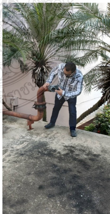
ภาพที่ 4.41 แสดงสาธิตการตรวจสอบหัวจ่ายน้ำดับเพลิง
