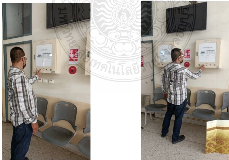
ภาพที่ 4.34 แสดงสาธิตการทดสอบการทำงานของกริ่งแจ้งเหตุและสัญญาณไฟของตู้ควบคุม
