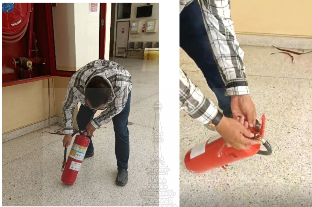
ภาพที่ 4.28 แสดงการตรวจสอบภายนอกถังดับเพลิงแบบมือถือ (ต่อ)
