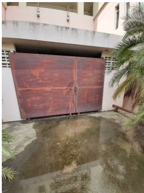
ภาพที่ 3.11 แสดงพื้นที่ด้านหน้าอาคารระบบน้ำดับเพลิง
