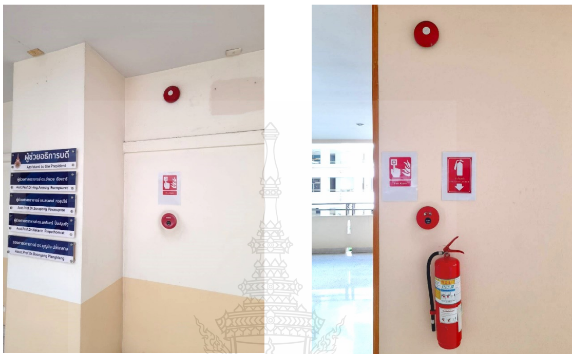
ภาพที่ 3.14 แสดงตำแหน่งติดตั้งอุปกรณ์เตือนภัยแบบมีเสียง
