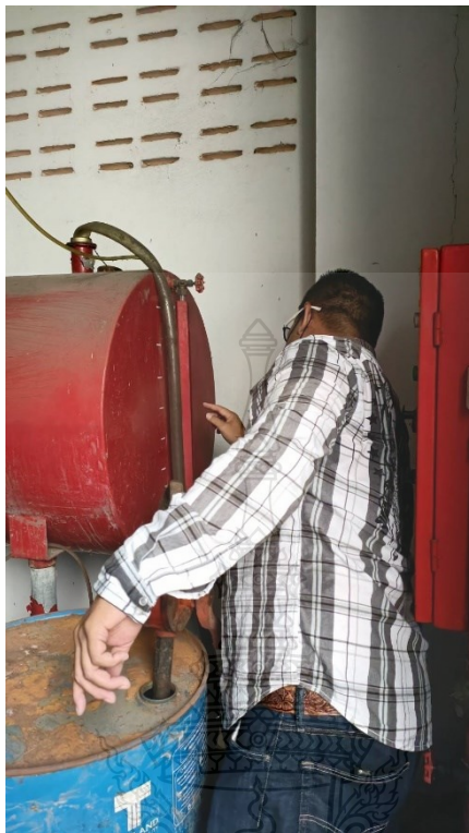
ภาพที่ 4.40 แสดงสาธิตการตรวจสอบระดับน้ำมันเชื้อเพลิง
