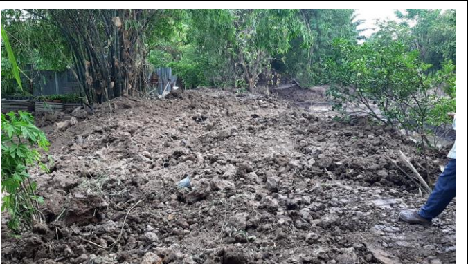
ภาพที่ 6.6.40 การปรับพื้นที่ภายในโครงการฯ
