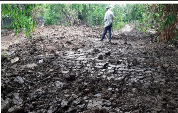
ภาพที่ 6.6.39 การปรับพื้นที่ภายในโครงการฯ
