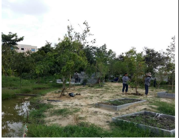
ภาพที่ 6.6.14 การปรับปรุงพื้นที่ภายในโครงการฯ
