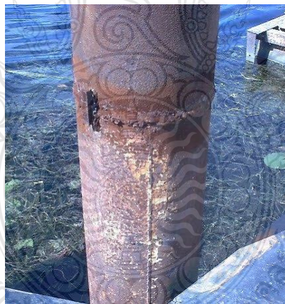
รูปที่ 2.3 ภาพการกัดกร่อนแบบที่เกิดขึ้นสม่ำเสมอทั่วผิวหน้า [13]
