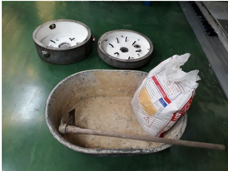
รูปที่ ค.4 การเตรียมงานเทคอนกรีตทนไฟ
