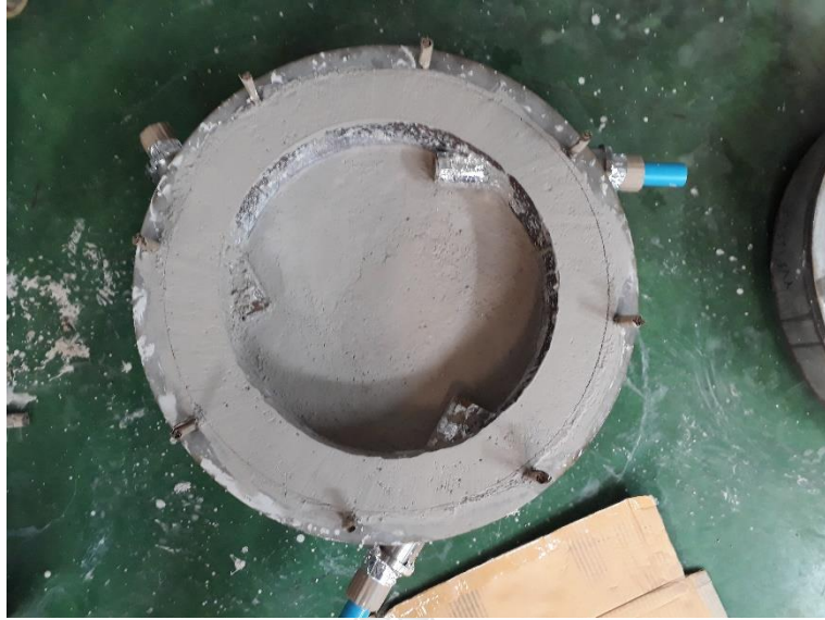
รูปที่ ค.7 การเทคอนกรีตทนไฟภายในห้องเผาไหม้
