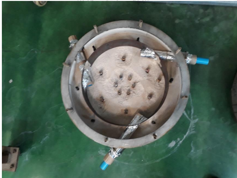
รูปที่ ค.6 การวางแบบหล่อคอนกรีตทนไฟ
