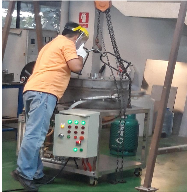
รูปที่ ค.17 ทดลองเดินระบบการเผาไหม้ และปรับจูนระบบ
