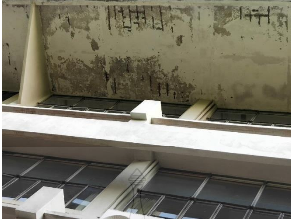
รูปที่ 4.2 การหลุดร่อนและแตกร้าวของปูนฉาบใต้ท้องระเบียง (วิทยาลัยสารพัดช่างอุดรธานี อาคารพานิชยกรรม)
