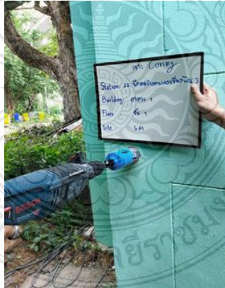
รูปที่ 3.5 สว่าน BOSCH หัวเจาะ HOLESAW
