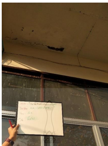
รูปที่ 4.4 ปัญหารอยร้าวชั้นปูนฉาบบริเวณเพดานของพื้นที่ชั้น 2 (วิทยาลัยสารพัดช่าง อาคารปฏิบัติการ วิชาชีพ)
