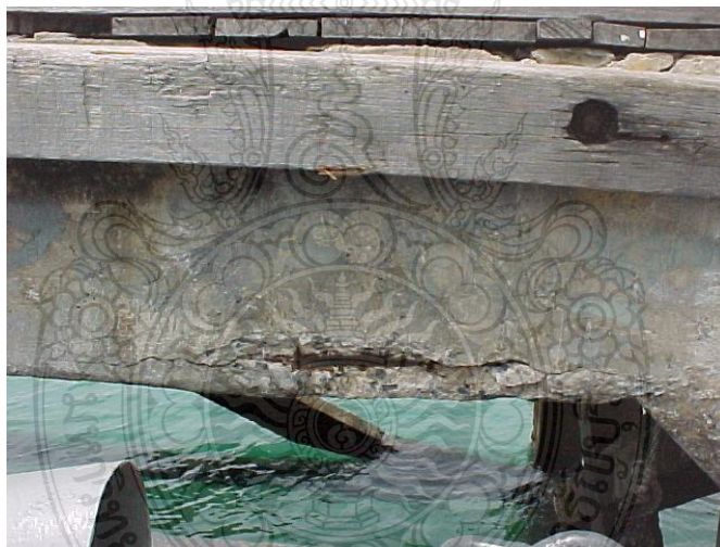
รูปที่ 2.5 ความเสียหายของคานคอนกรีตเสริมเหล็ก เนื่องจากการเกิดสนิมของเหล็กเสริม ทำให้คอนกรีตที่หุ้มเหล็กเสริมหลุดร่อนออกทั้งหมด ซึ่งเป็นผลมาจากแรงดันที่เกิดขึ้นจากผลิตภัณฑ์ของการเกิดสนิม และการเกิดสนิมยังทำให้พื้นที่หน้าตัดของเหล็กเสริมมีขนาดเล็กลง [1]
