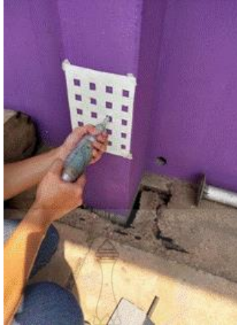
รูปที่ 3.4 วิธีการทดสอบกำลังอัดประลัยของโครงสร้างคอนกรีต โดยใช้ค้อนกระแทกแบบชมิคท์ (Schmidt Hammer)
