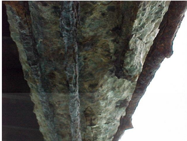
รูปที่ 2.5 ความเสียหายของคานคอนกรีตเสริมเหล็ก เนื่องจากการเกิดสนิมของเหล็กเสริม ทำให้คอนกรีตที่หุ้มเหล็กเสริมหลุดร่อนออกทั้งหมด ซึ่งเป็นผลมาจากแรงดันที่เกิดขึ้นจากผลิตภัณฑ์ของการเกิดสนิม และการเกิดสนิมยังทำให้พื้นที่หน้าตัดของเหล็กเสริมมีขนาดเล็กลง [1]
