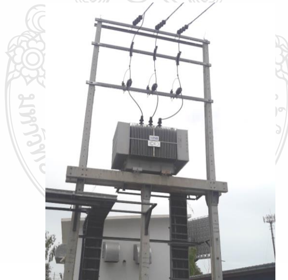
รูปที่ 2.20 หม้อแปลงไฟฟ้ากำลังแบบยกแรงดันไฟฟ้า
