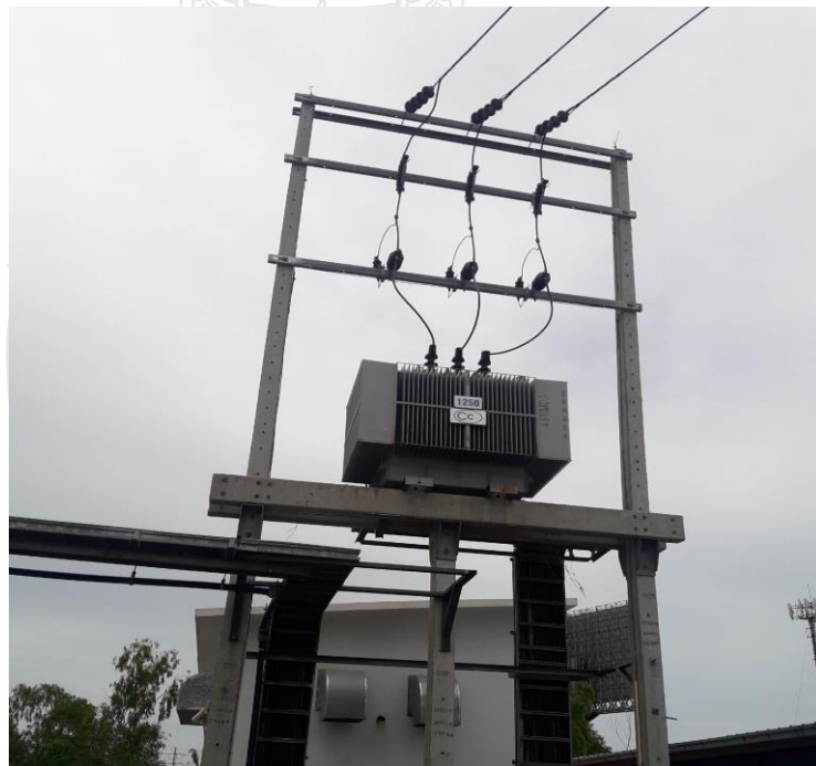
รูปที่ 3.3 การติดตั้งหม้อแปลงไฟฟ้าบนเสาขนาด 1,250 kVA แบบยกแรงดันไฟฟ้า
