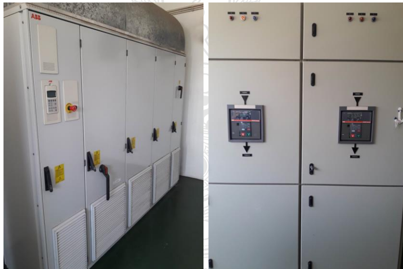
รูปที่ 3.5 ห้อง MDB และอินเวอร์เตอร์
