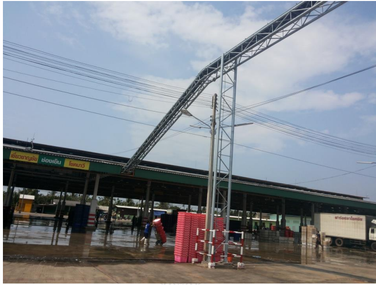
รูปที่ 3.6 การเดินสายป้อนจากกล่องต่อแยกสายรวมของแผงเซลล์แสงอาทิตย์แบบติดตั้งบนหลังคาไปยังห้องไฟฟ้าแบบติดตั้งกลางแจ้ง
