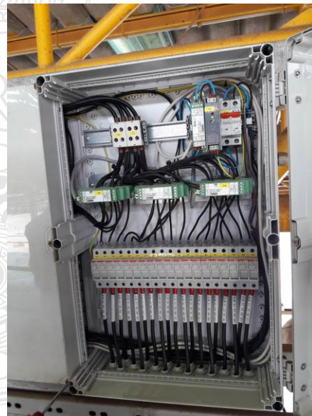
รูปที่ 3.6 การเดินสายป้อนจากกล่องต่อแยกสายรวมของแผงเซลล์แสงอาทิตย์แบบติดตั้งบนหลังคาไปยังห้องไฟฟ้าแบบติดตั้งกลางแจ้ง
