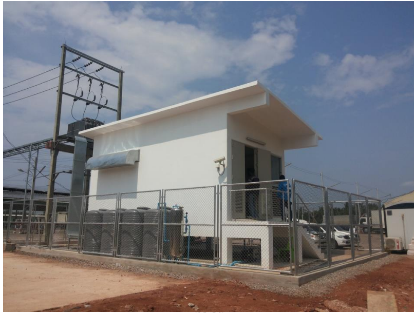
รูปที่ 3.4 ห้องไฟฟ้าแบบติดตั้งกลางแจ้งสำหรับติดตั้งตู้จ่ายไฟ และอินเวอร์เตอร์ สำหรับสถานีไฟฟ้า ขนาดใหญ่ 1 เมกะวัตต์
