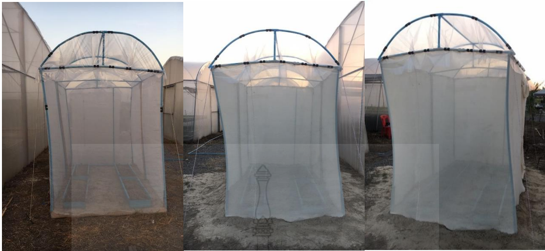
รูปที่ 3.23 โรงเรือนที่คลุมผ้าเสร็จ
