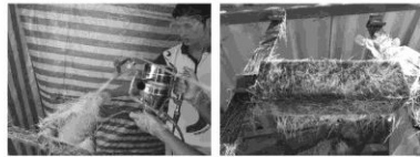
ภาพที่ 4 เสริมกำลังด้วย GFRP Sprayed
