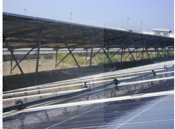
รูปที่ 6 ลักษณะของการติดตั้งระบบสเปรย์น้ำเพื่อลดอุณหภูมิ [4]
