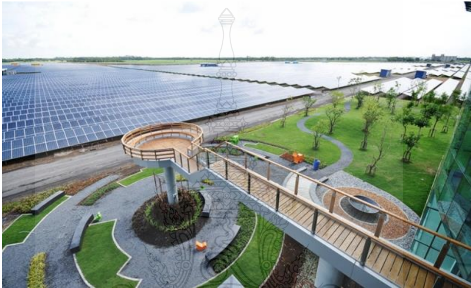
รูปที่ 1.1 โซลาร์ฟาร์มที่ จ.พระนครศรีอยุธยาผลิตไฟฟ้าเชิงพาณิชย์ กำลังผลิต 38MW
