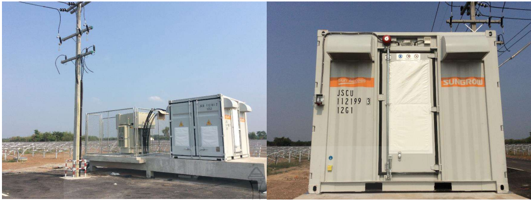
รูปที่ 3.26 อินเวอร์เตอร์ที่ทำการติดตั้งบนนั่งร้าน คสล.
