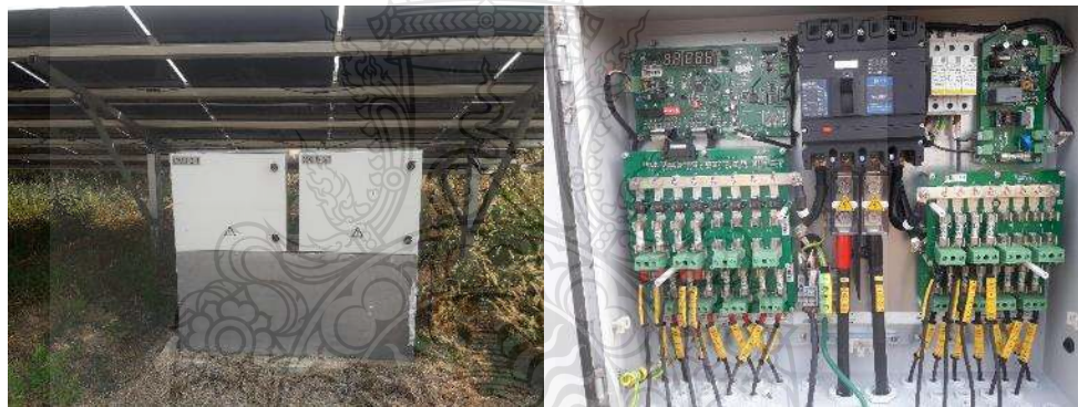
รูปที่ 3.20 กล่องต่อรวมสาย (Combiner Box)
