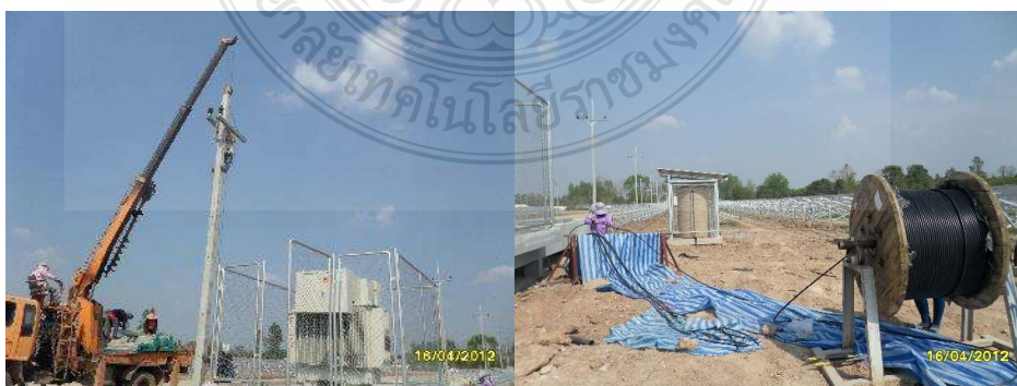
รูปที่ 3.24 การเดินสายไฟฟ้าภายในโครงการ
