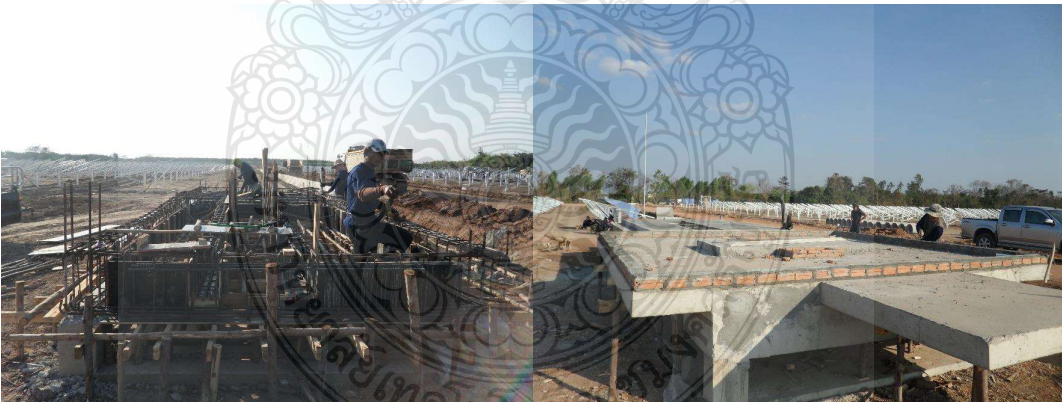
รูปที่ 3.22 การก่อสร้างสถานีไฟฟ้าย่อย
