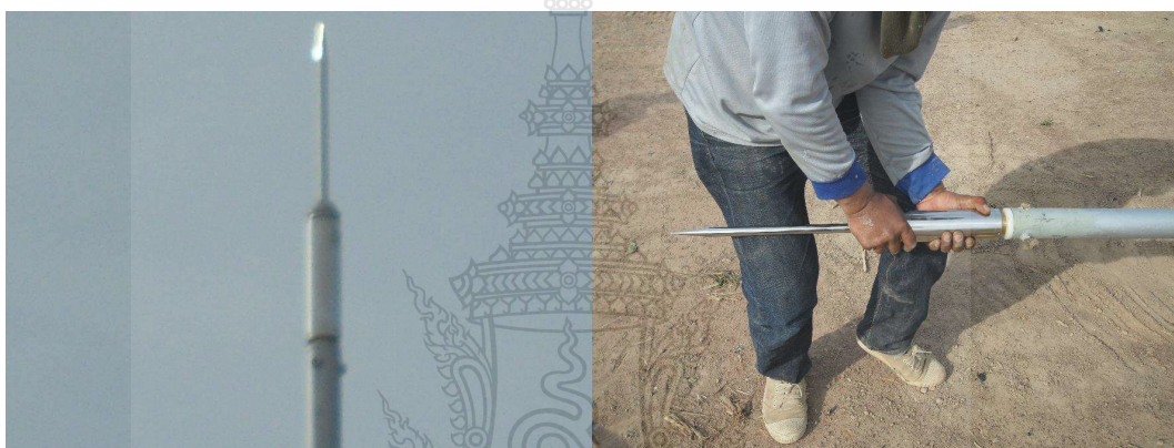
รูปที่ 3.28 เสาตัวนำต่อฟ้าผ่า
