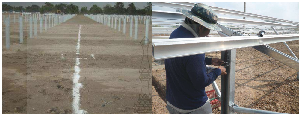
รูปที่ 3.23 การประกอบโครงสร้างเพื่อรองรับน้ำหนักแผงเซลล์แสงอาทิตย์
