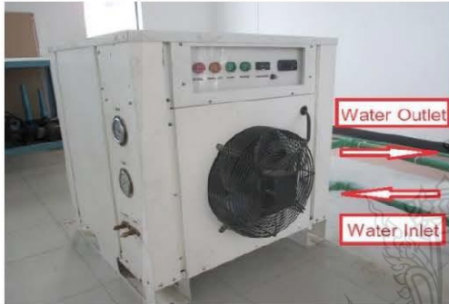
รูปที่ 3 ปั๊มความร้อนขนาด 16 kW
