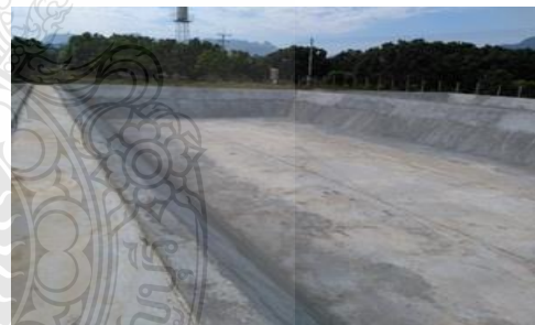
ข) บ่อหมักจะเป็นพื้นคอนกรีต
