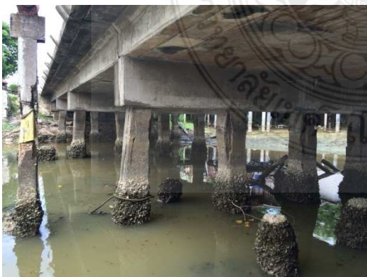
รูปที่ 2.2 ตัวอย่างความเสียหายเนื่องจากการเกิดสนิมของเหล็กเสริมในคอนกรีตเนื่องจากเกลือคลอไรด์
