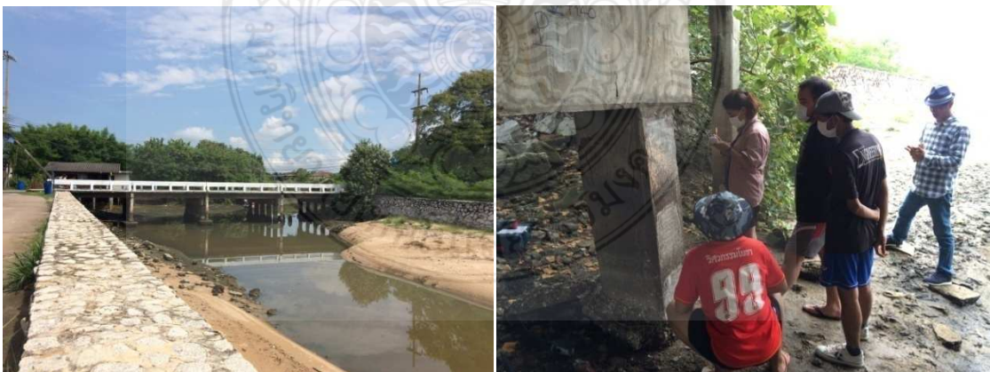
รูปที่ 3.12 ภาพถ่ายสถานที่จริงสะพาน คสล. โดยทำการเก็บตัวอย่างผงคอนกรีตจากผนังเสาตอม่อและคาน
