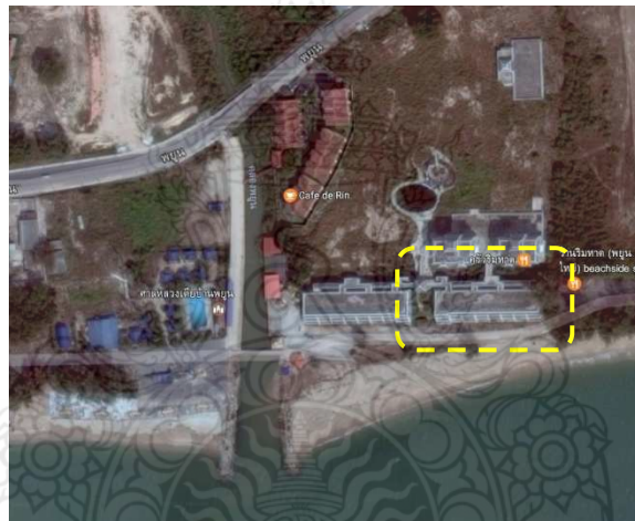
รูปที่ 3.1 ตำแหน่งที่ตั้งอาคาร ค.ส.ล. 3 ชั้น ตั้งอยู่บริเวณชายฝั่งทะเล ต.บ้านฉาง อ.บ้านฉาง จ.ระยอง
