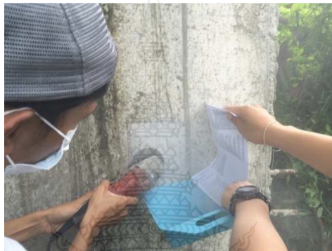
รูปที่ 3.14 การตัดผิวหน้าของโครงสร้างคอนกรีตเสริมเหล็กเพื่อเก็บตัวอย่างผงคอนกรีต
