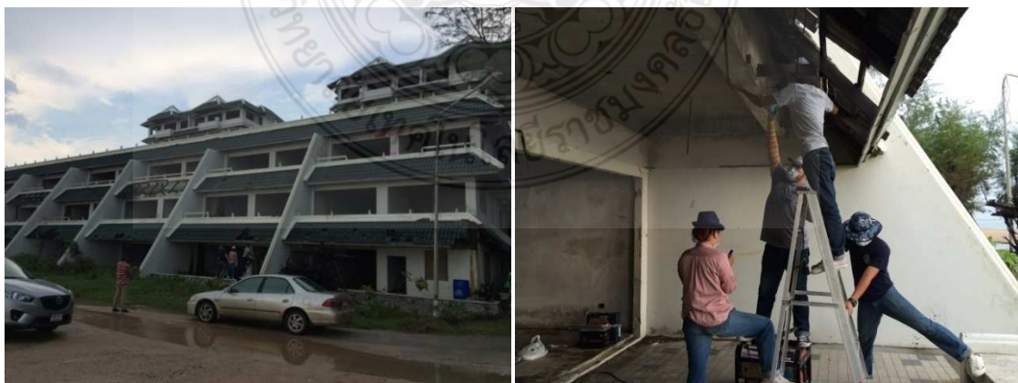
รูปที่ 3.2 ภาพถ่ายสถานที่จริงอาคารค.ส.ล. 3 ชั้น โดยทำการเก็บตัวอย่างผงคอนกรีตจากคานและเสา
