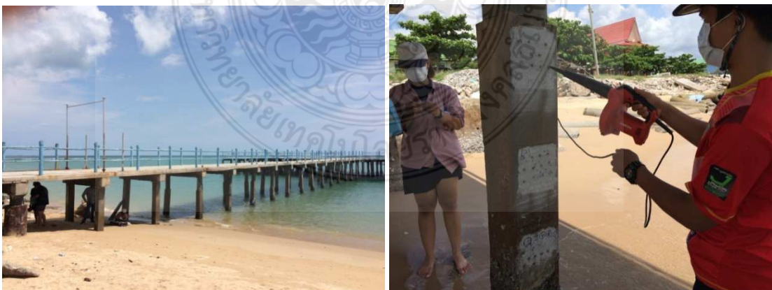
รูปที่ 3.8 ภาพถ่ายสถานที่จริงท่าเทียบเรือสะพานปลา (ตัวที่ 2) โดยทำการเก็บตัวอย่างผงคอนกรีตจากคาน และเสา
