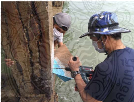
รูปที่ 3.15 การเจาะตัวอย่างผงคอนกรีตเพื่อหาการกระจายตัวของสารแทรกซึมของเกลือคลอไรด์ในโครงสร้างคอนกรีตเสริมเหล็ก
