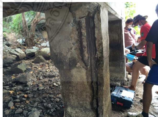
รูปที่ 2.2 ตัวอย่างความเสียหายเนื่องจากการเกิดสนิมของเหล็กเสริมในคอนกรีตเนื่องจากเกลือคลอไรด์
