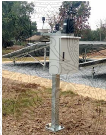
รูปที่ 3.14 สถานีโทรมาตรบริเวณแผงโซลาร์เซลล์ที่ติดตั้งบนพื้นดิน
