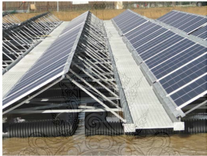
รูปที่ 2.22 โครงสร้างการติดตั้งแผงโซลาร์เซลล์บนแพของบริษัท Terra Moretti [15]
