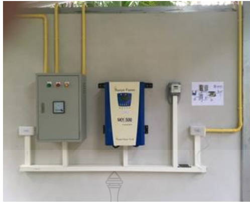
รูปที่ 3.8 การติดตั้งระบบควบคุมการทำงานกังหันน้ำ ขนาด 5 กิโลวัตต์ แล้วเสร็จ
