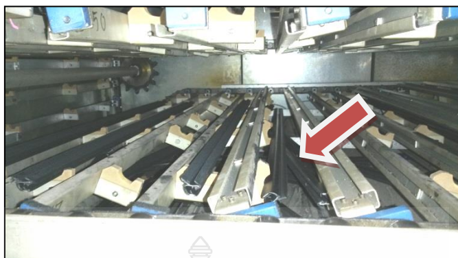
ภาพที่ 3.10 แสดงลักษณะของปัญหาชิ้นงานตกตู้ โดยที่ตัวชิ้นงานไม่ได้วางอยู่บนรางวางชิ้นงานจัด และพันกันภายในตู้อบชิ้นงาน
