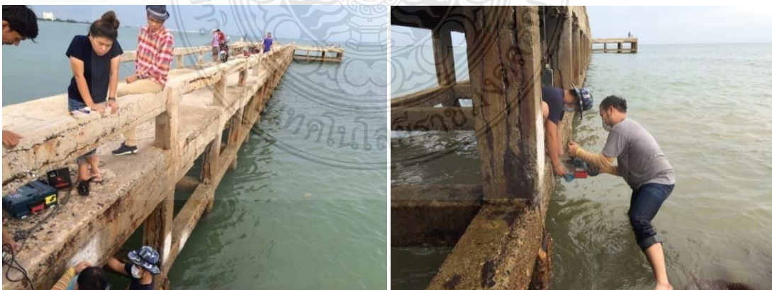
รูปที่ 3.6 ภาพถ่ายสถานที่จริงท่าเทียบเรือสะพานปลา (ตัวที่ 1) โดยทำการเก็บตัวอย่างผงคอนกรีตจากคาน เสา และราวกันตก
