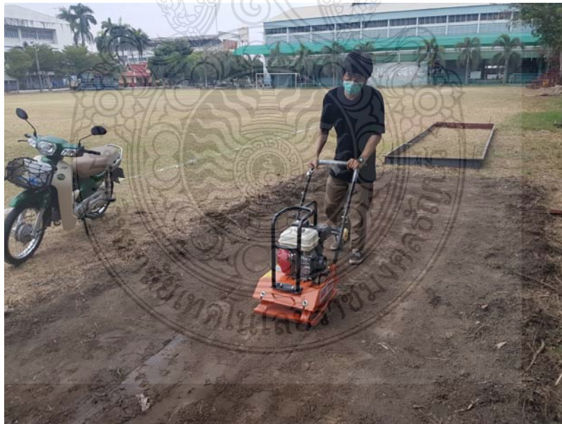
รูปที่ 3.7 เครื่องบดอัดดินในสนาม
