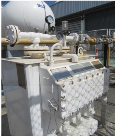
รูปที่ 3.16 เครื่องช่วยระเหย (Vaporization Tank Heaters System)
