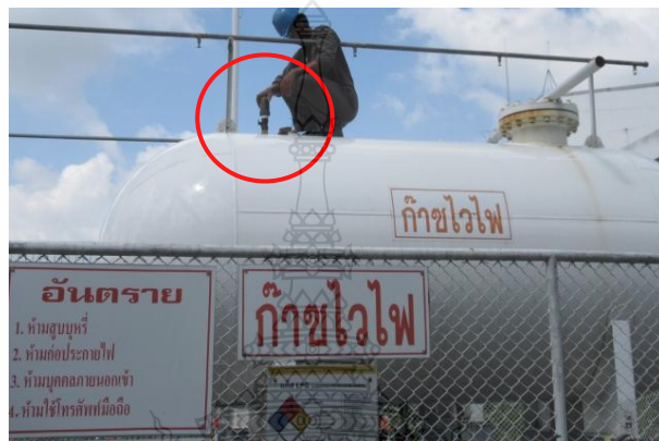
รูปที่ 3.22 ตำแหน่งการระบายก๊าซบนดังกักเก็บ
