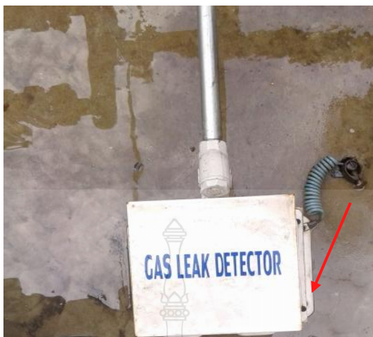
รูปที่ 3.14 ลักษณะข้อบกพร่องของตัวอุปกรณ์สัญญาณจับก๊าซรั่วซึม
