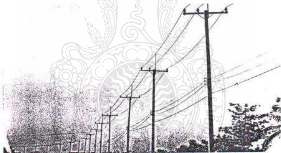
รูปที่ 2.4 สายจำหน่ายแรงสูง หรือ สายป้อน [13]
