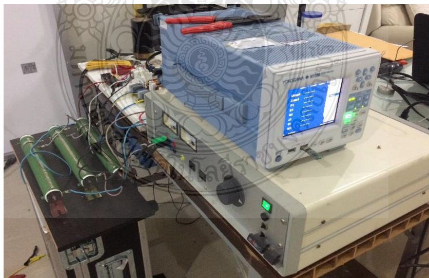
รูปที่ 4.13 ภาพ Power Meter WT500 ขณะต่อใช้งานในโครงการ
