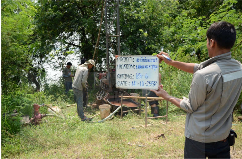
รูปที่ 3.4 แสดงตัวอย่างการเตรียมเครื่องจักรสำหรับการเจาะสำรวจดินในหลุมเจาะ BH-06
