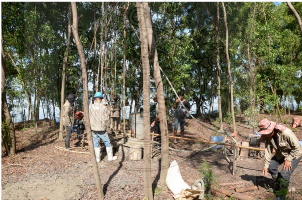
รูปที่ 3.5 แสดงตัวอย่างการเจาะสำรวจแบบฉีดล้าง (Wash Boring) ในหลุมเจาะ BH-08
