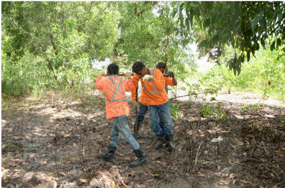
รูปที่ 3.11 แสดงเจาะหลุมติดตั้งบ่อสำรวจระดับน้ำ (Standpipe piezometer)
